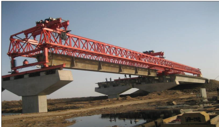
Figure X.1.Exemple des poutres posées par lancement.
