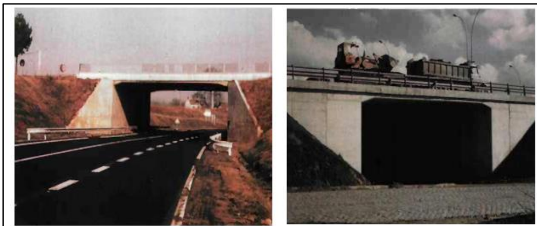
Figure I-5. Ouvrage avec murs en ail et retour.
