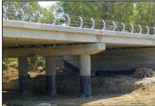
Figure I-8. Pont à poutres.
