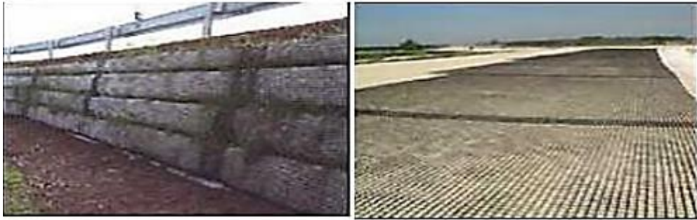
Figure 10 : renforcement par géosynthétique [19]
