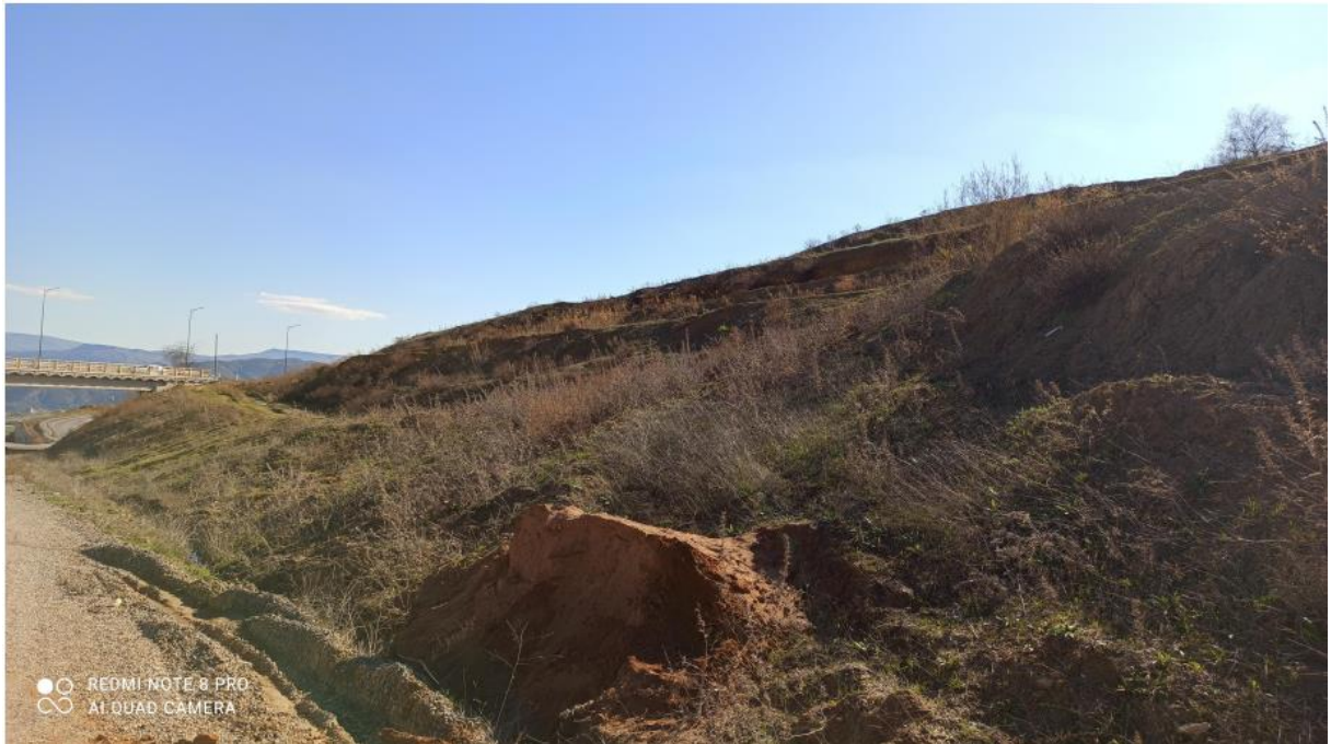
Figure 02 : Aperçu sur le talus réel
