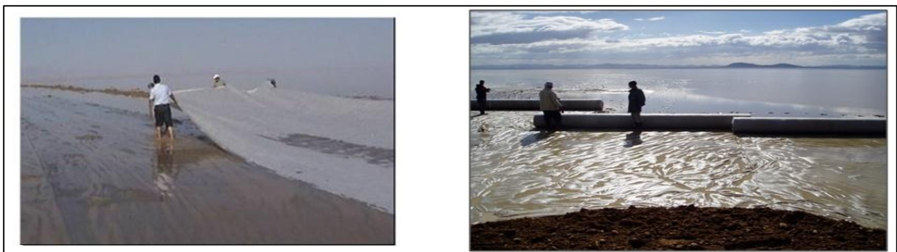
Figure 7 : Pose des Géotextiles de séparation
