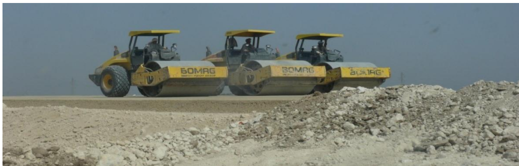
Figure 2 photo prise d'un compactage
