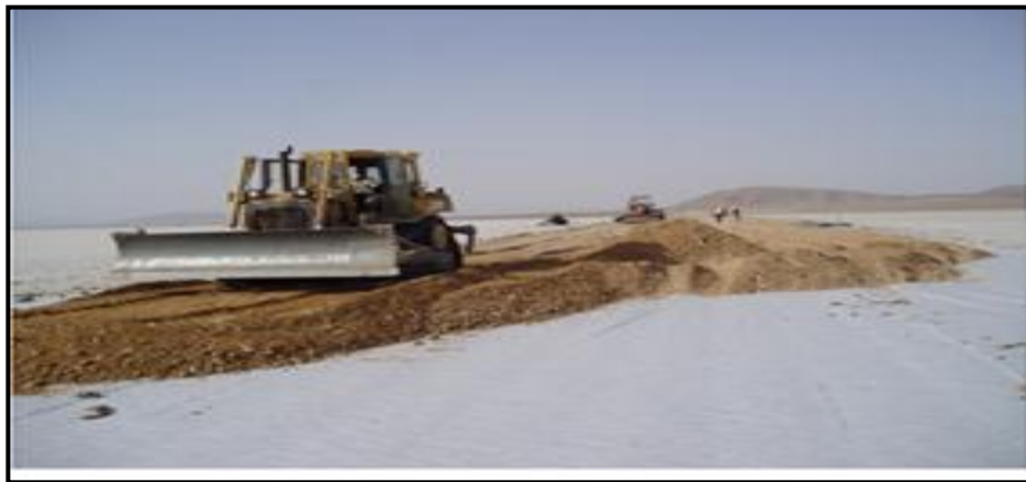
Figure 8 : Mise en place de la 1 ère couche du remblai
