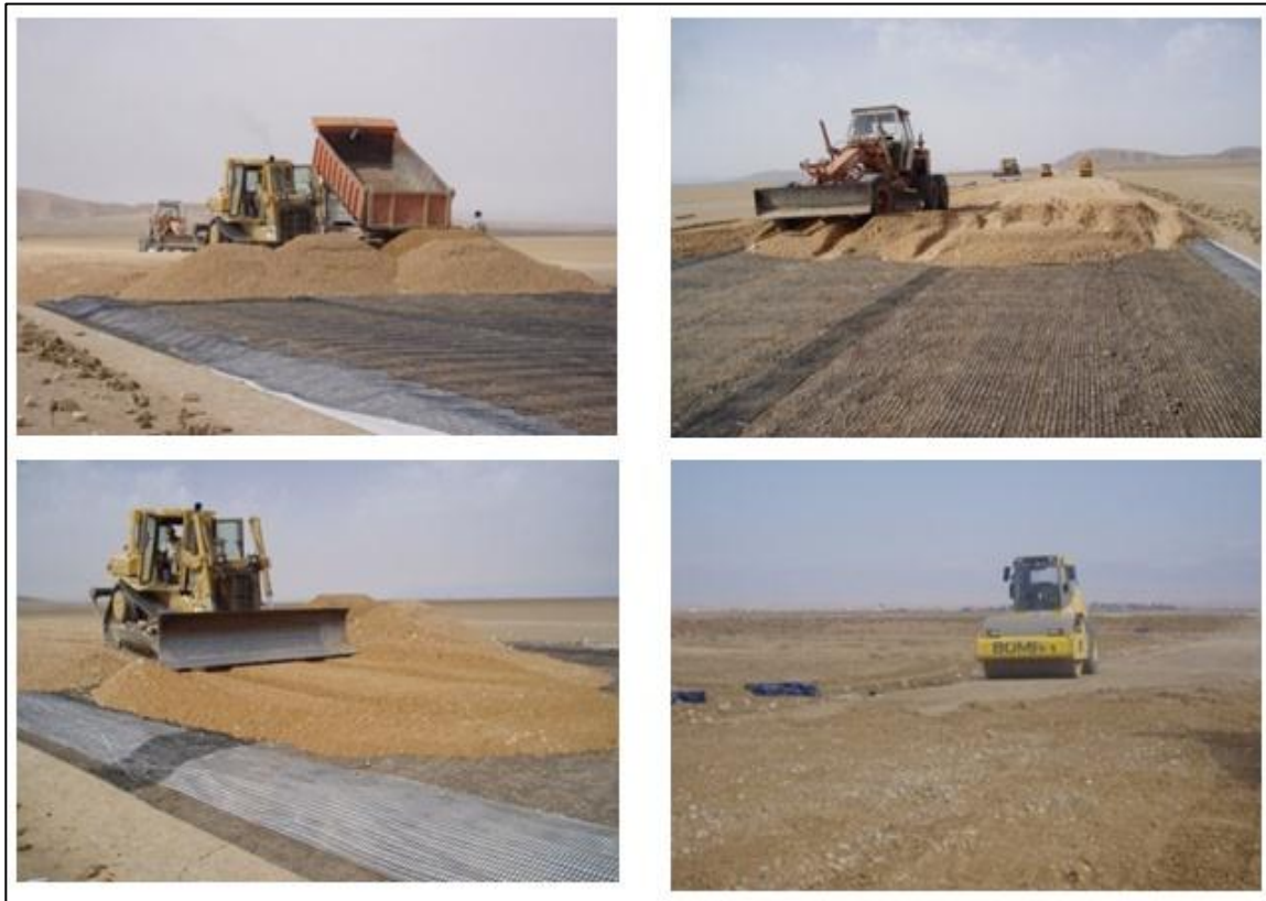
Figure 10 : La mise en place des remblais
