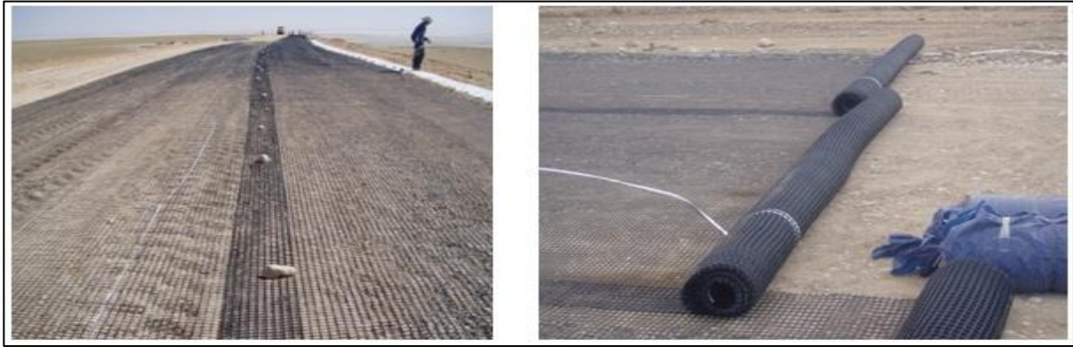
Figure 9 Recouvrement du géogrille
