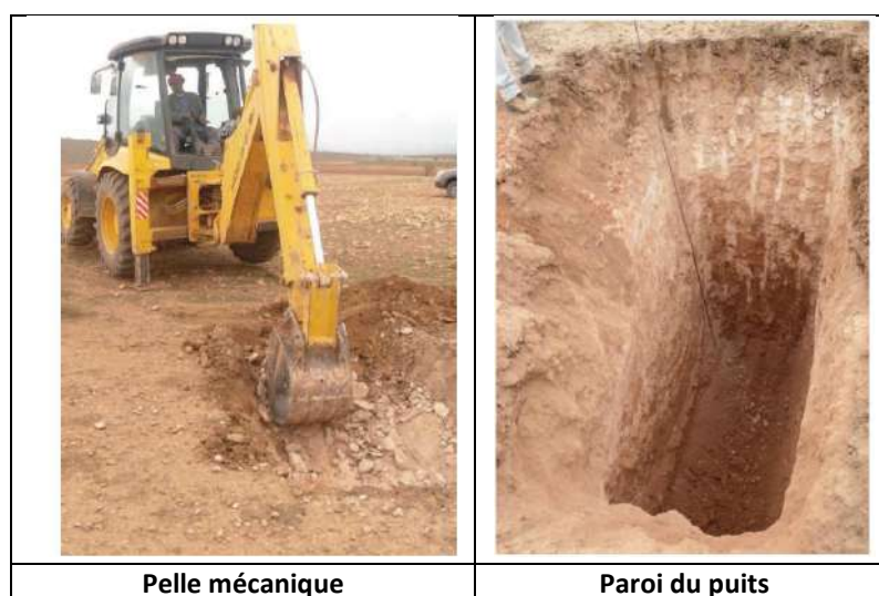
Figure.IV.4. Réalisation des puits.
