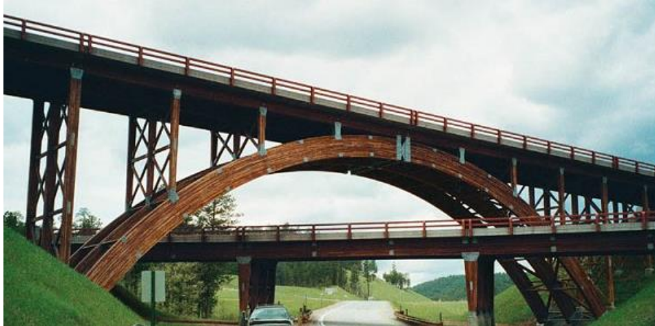
Figure I.5 Exemple d'un pont en bois
