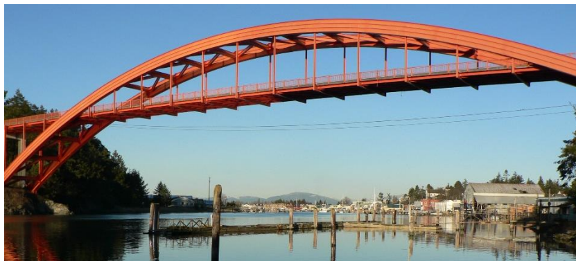
Figure I.6 Exemple pont en arc
