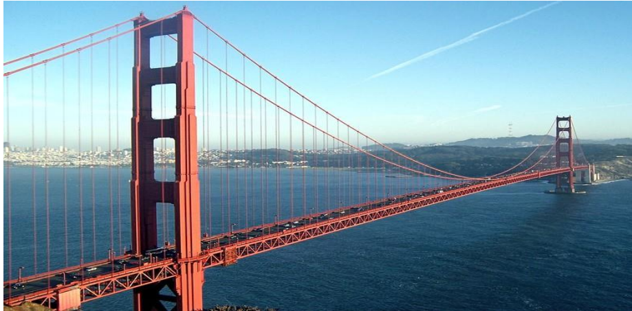
Figure I.7 Exemple d'un pont suspendue
