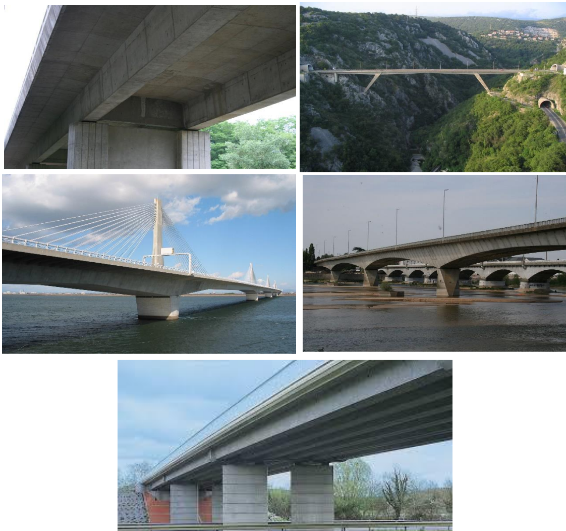
Figure I.2 Exemple des ponts en béton précontraint.
