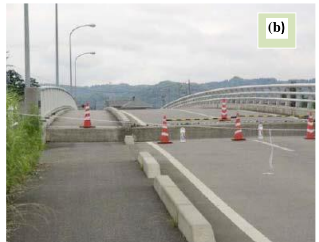
Figure 1.17 : Tassement différentiel dû au compactage sismique au droit du remblai d'accès à l'ouvrage, a) Séisme de Myanmar en 2001 (Burma)/ (Anbazhagan et al., 2011), b) Séisme de Niigata-Chuetsu Oki en 2007 (Japon)/ (Syner-G D3.7, 2009).
