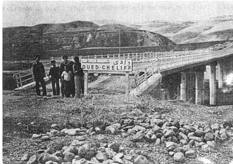
Figure 1.16 : Tassement de près de 1 m dû au compactage sismique au droit du remblai d'accès à l'ouvrage - Séisme d'El Asnam de 1980 (Algérie) (EERI/CTC, 1980).
