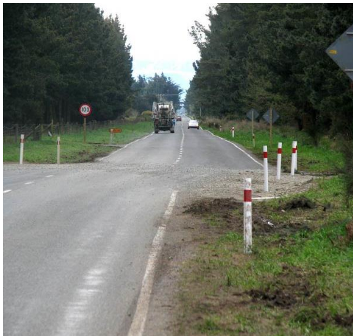
Figure 1.4 : Endommagement d'une route par la rupture de faille (faille décrochante) -Séisme de Canterbury en 2010 (N.Zélande) /(ENZ,2010).
