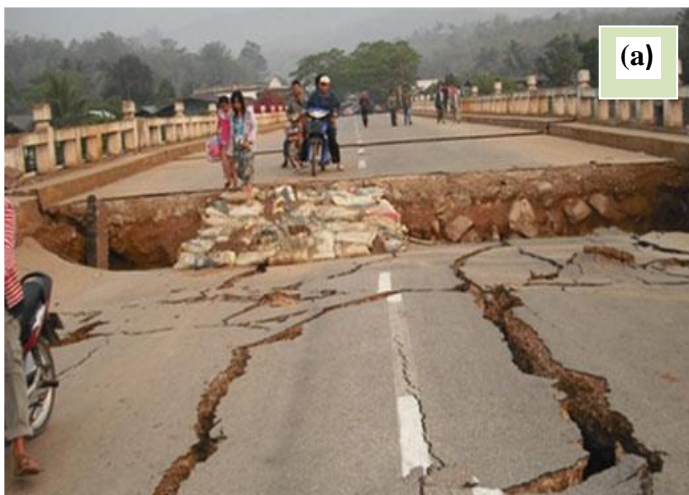
Figure 1.17 : Tassement différentiel dû au compactage sismique au droit du remblai d'accès à l'ouvrage, a) Séisme de Myanmar en 2001 (Burma)/ (Anbazhagan et al., 2011), b) Séisme de Niigata-Chuetsu Oki en 2007 (Japon)/ (Syner-G D3.7, 2009).
