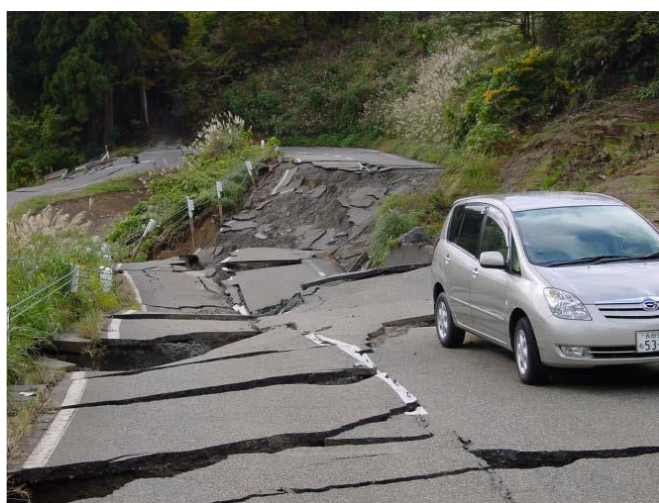
Figure 1.19: Destruction de routes due aux glissements de terrain Séisme de Niigata-Ken Chuetsu en 2004 (Japon)/(Syner-G D3.7, 2009).
