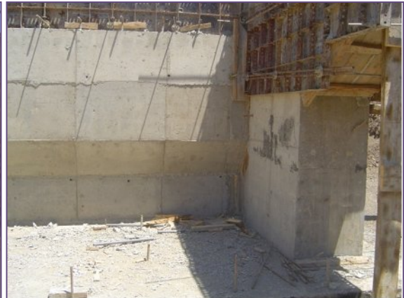
Photo°8 : coffrage du mur en retour.
