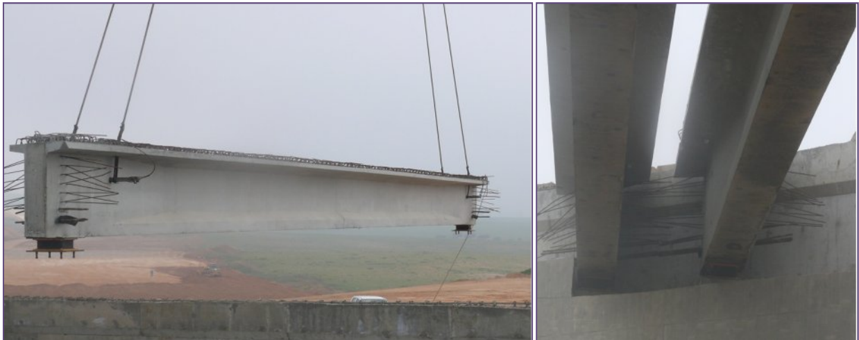
Photo°9 ; 10 : exemple sur la pose des poutres
