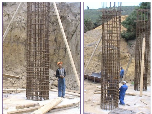
Photo° 3 ; 4 : mise en place du ferrailage du fut
