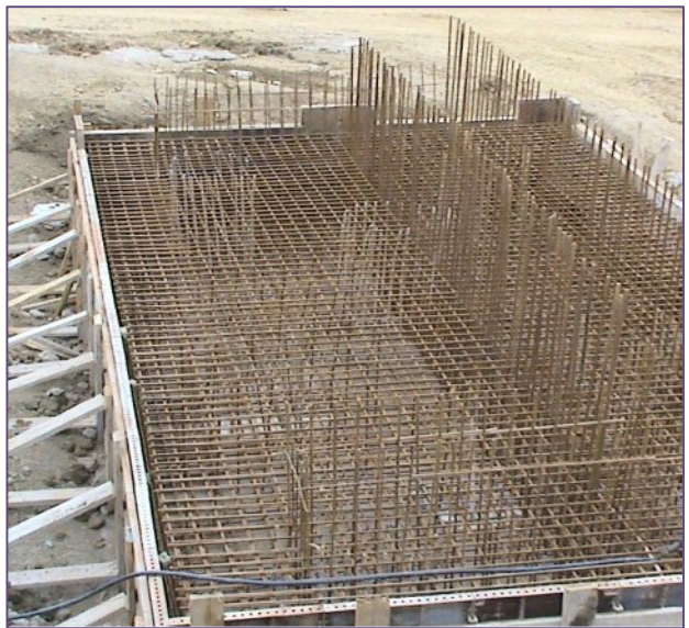
Photo° 2 : ferrailage de la semelle
