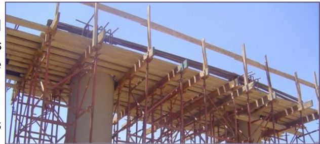
Photo°6: coffrage du fut
