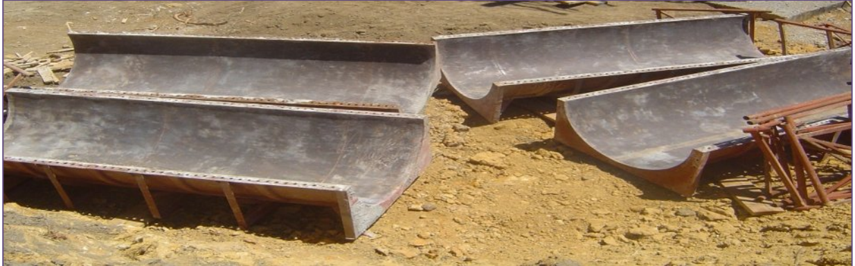
Photo°5 : coffrage du fut
