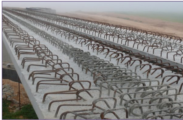
Photo°11 : exemple sur armatures de jonction
