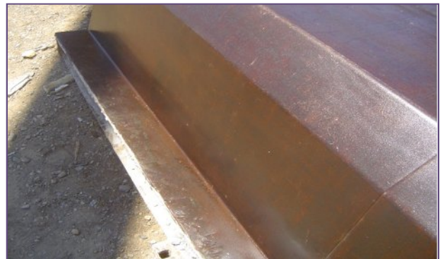
Photo°12 : Coffrage+d'huile de décoffrage
