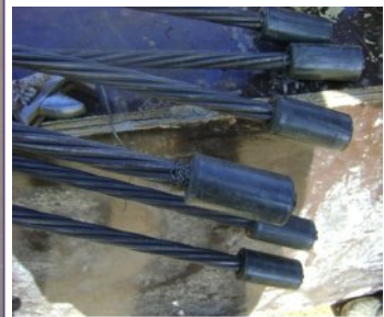
Photo°17 ; 18 : exemple sur l'ancrage fixe
