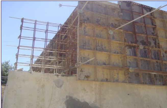
Photo°7 : coffrage du mur garde grève.
