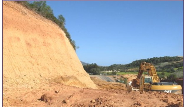
Photo° 1: les terrassements
