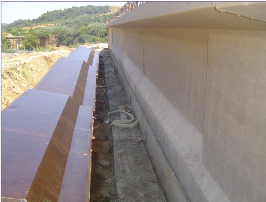
Photo°16 : la forme de la poutre après décoffrage
