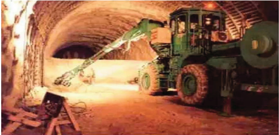
Figure I-7 : creusement calote-stross
