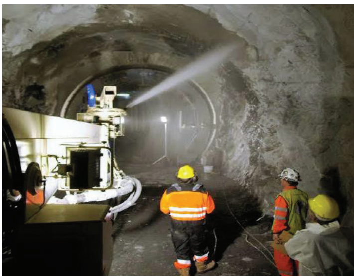
Figure I-13 : béton projeté
