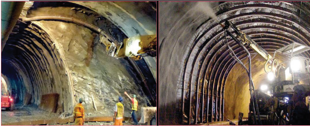
Figure I-11 : les cintres métalliques
