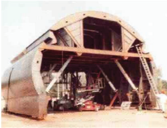
Figure I-14: coffrage du revêtement définitif
