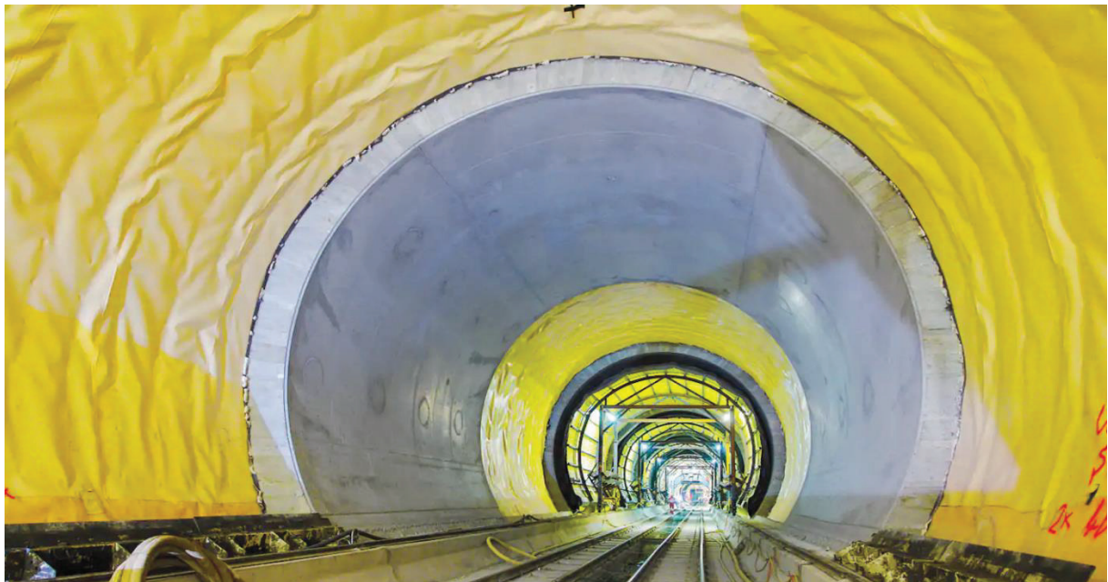
Figure I-15 : étanchéité des tunnels
