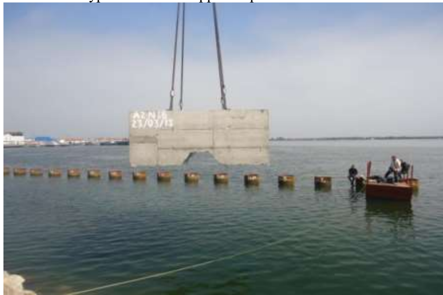
Figure VII.32 : Mise en place des éléments Préfabriqués
