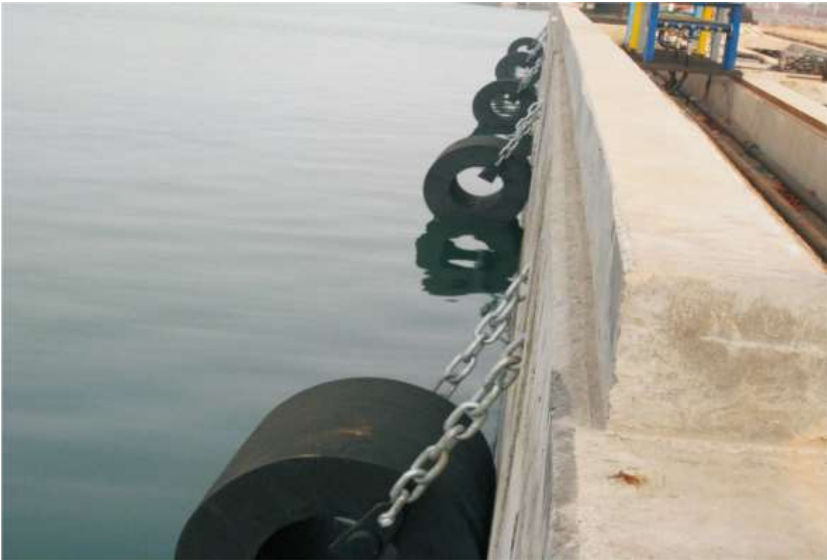
Figure II.15 : Défense cylindrique
