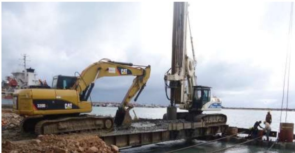
Figure VII.30 : Forage et curage des pieux
