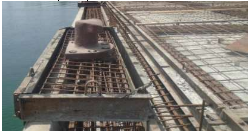
Figure VII.34 : la mise en place d'armature pour de la poutre de couronnement
