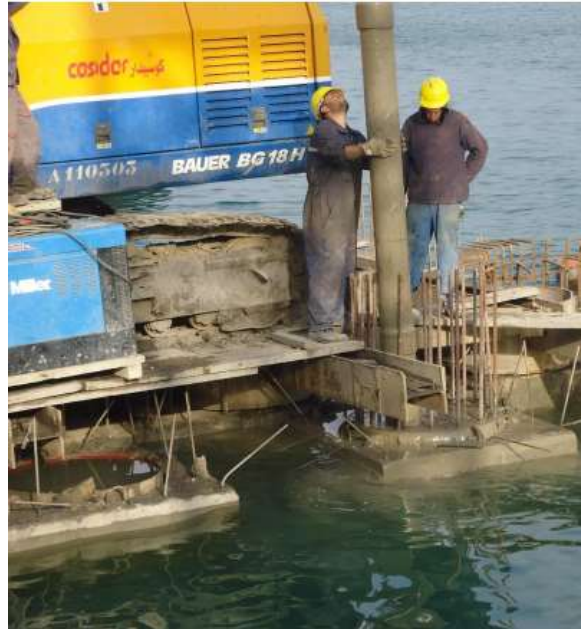
Figure VII.31 : Mise en œuvre béton de pieux
