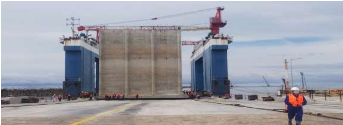
Figure II. 10 : exemple d'un caisson
