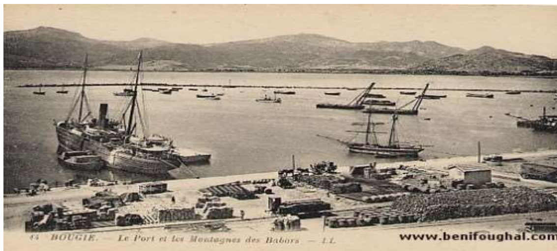
Figure III.1 : ancienne photo du port de BEJAIA.
