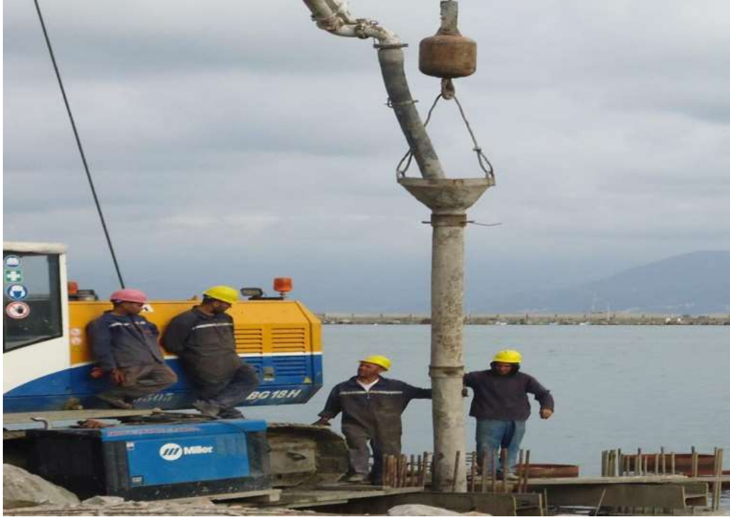
Figure VII.33 : Mise en œuvre du béton immergé
