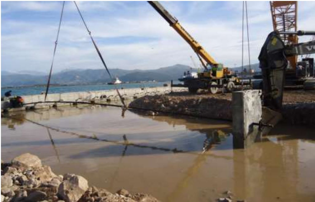
Figure VII.35 : la mise en place des tirants d'ancrage
