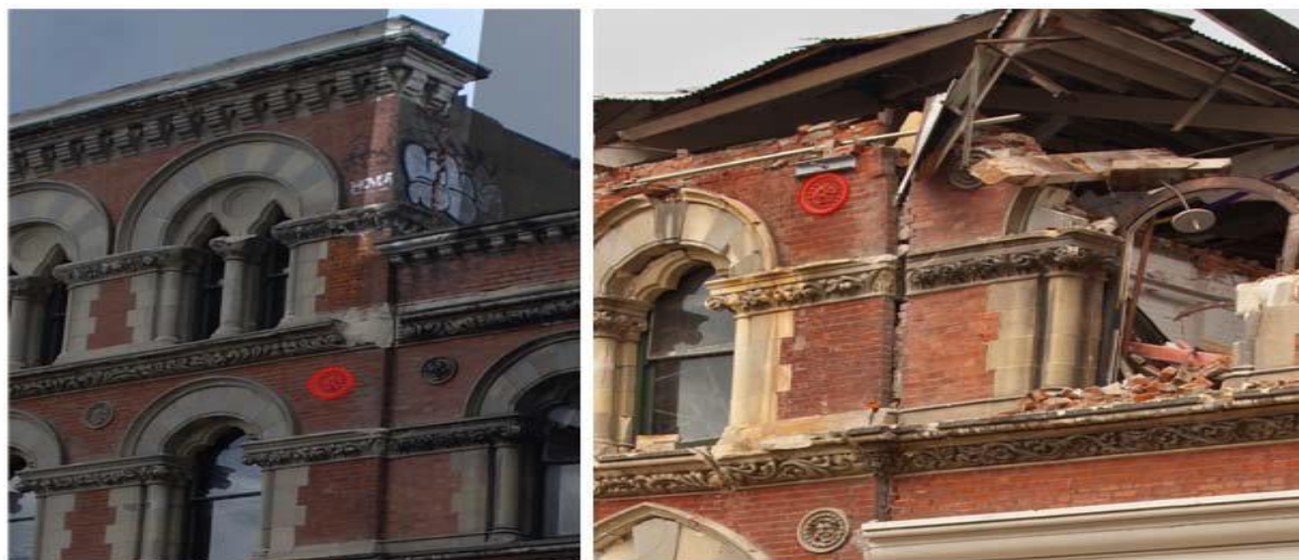
Figure 1.15 : Photos de deux bâtiments adjacents avant et après le séisme de Christchurch 2011.
