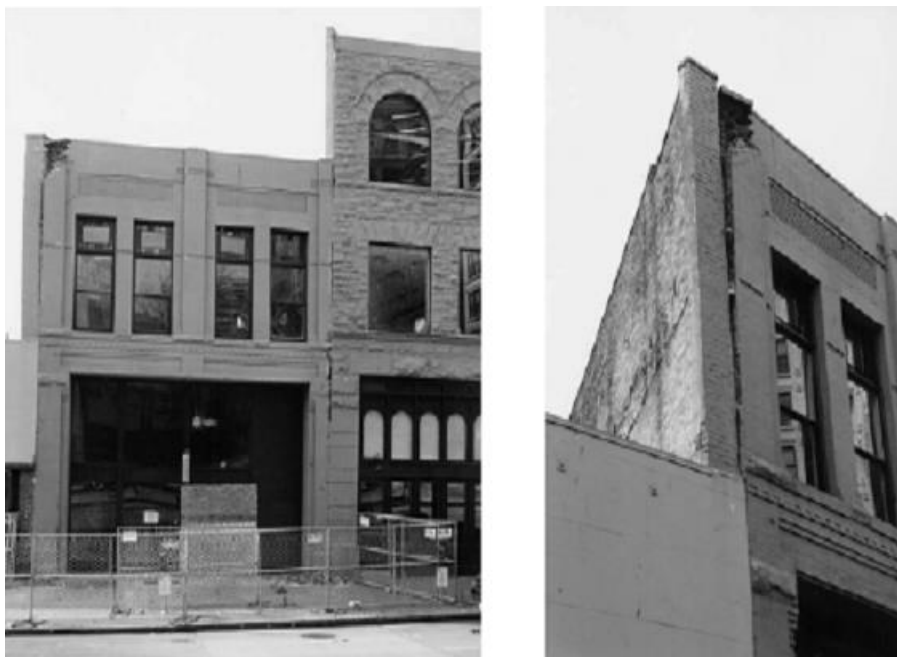
Figure 1.20 : Séparation des deux bords des bâtiments adjacents.
