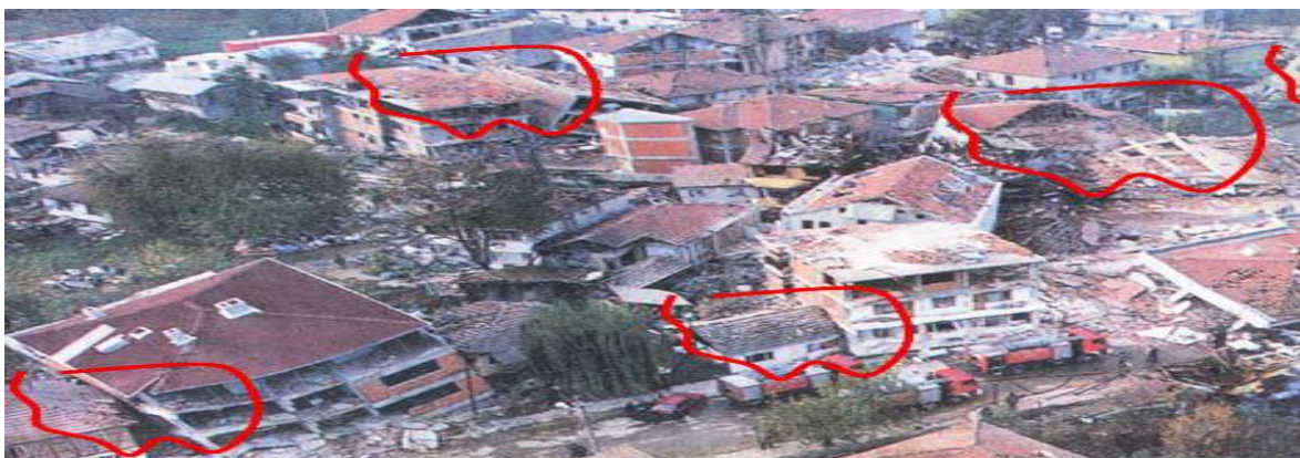
Figure 1.2 : Entrechoquement entre des bâtiments adjacents lors du séisme d'Izmit 1999.
