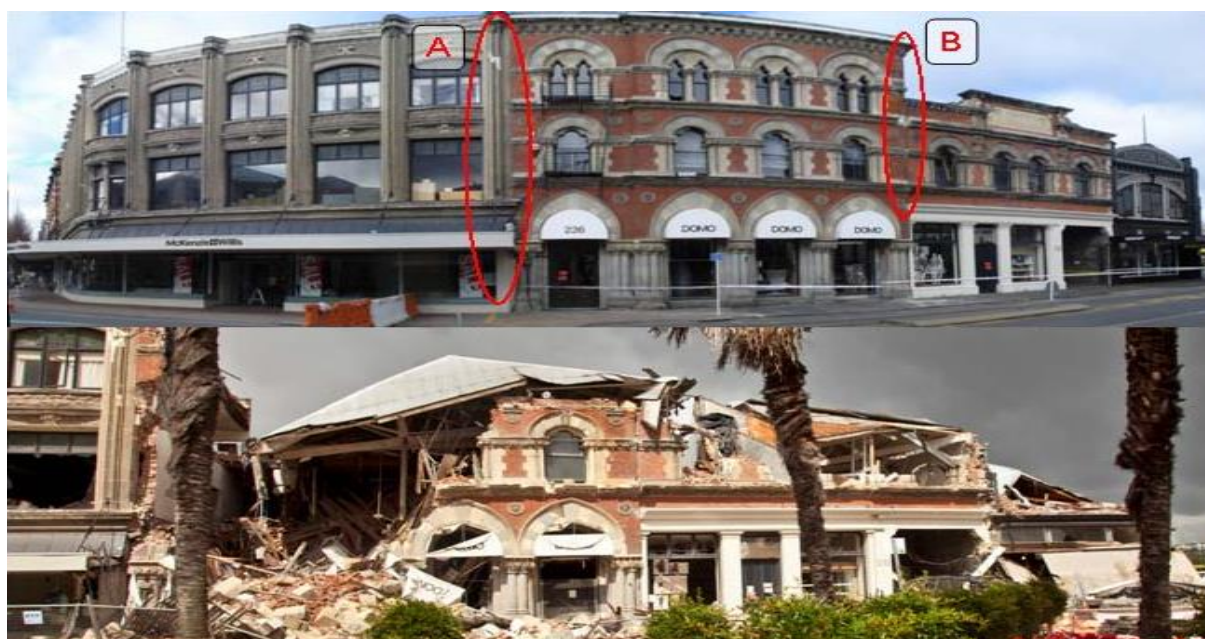
Figure 1.3 : Photos de trois blocs adjacents avant et après le séisme de Christchurch 2011.
