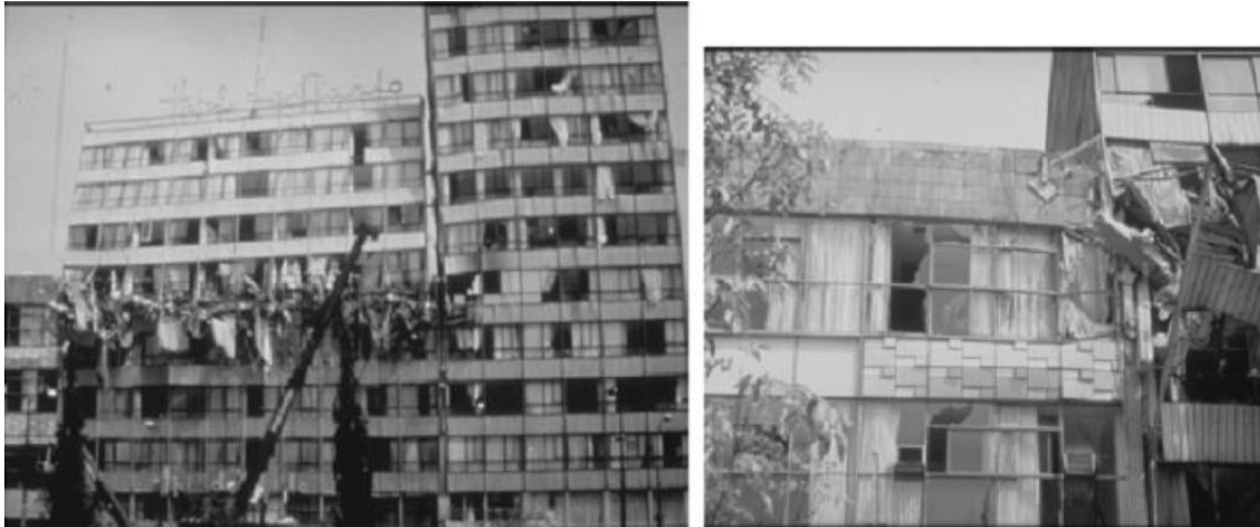
Figure 1.21 : Effondrement des planchers du milieu (Mexique, 1985).
