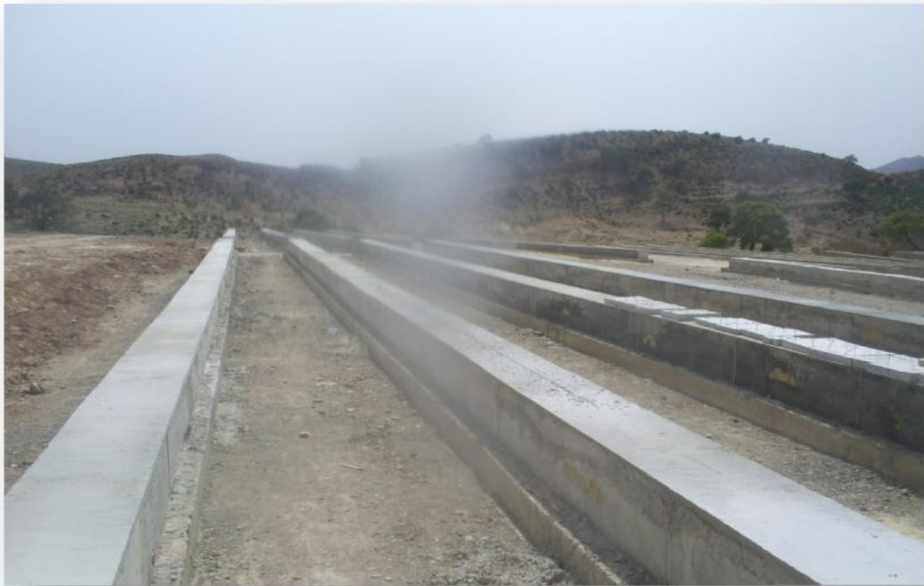
Réalisation des poutres pour le pont de Oued Mellegue.
