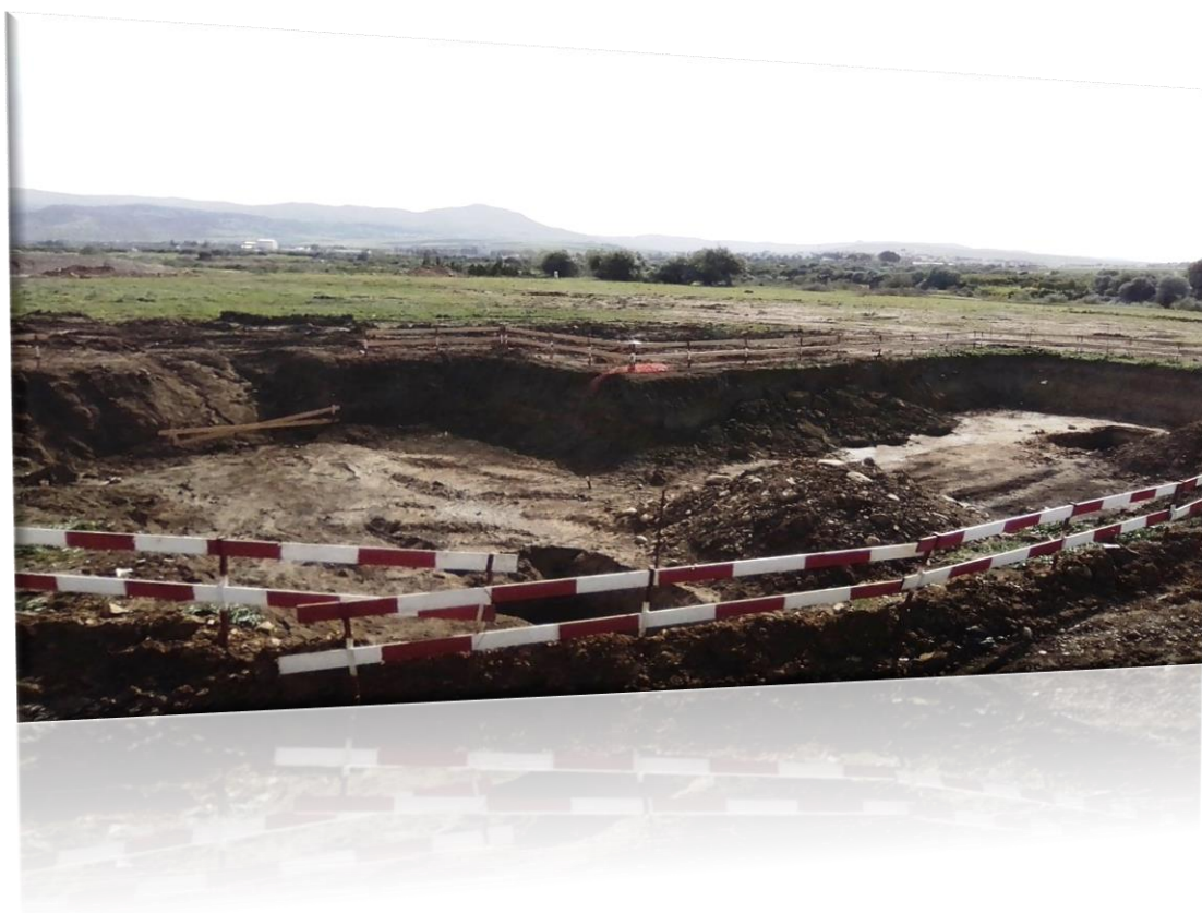
Position de la culée 2
