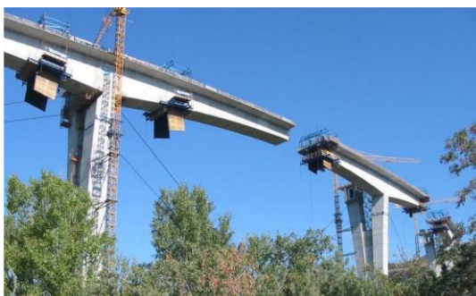
Figure X.1. Construction du viaduc de Crni Kal (Croatie) à l'aide d'équipages mobiles
