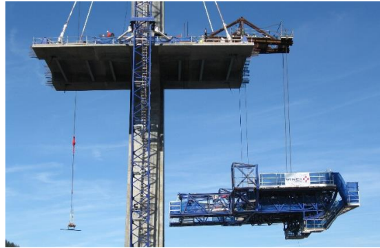
Figure X.3. Installation d'un équipage mobile haubané sur le pont de Térénez (France)
