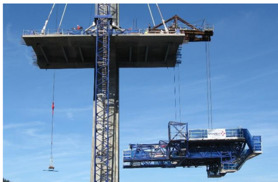
Figure X.3. Installation d'un équipage mobile haubané sur le pont de Térénez (France)
