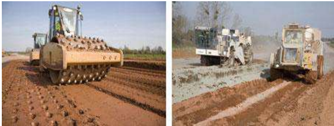
Figure I.1 : exécution d'un liant hydraulique routier
