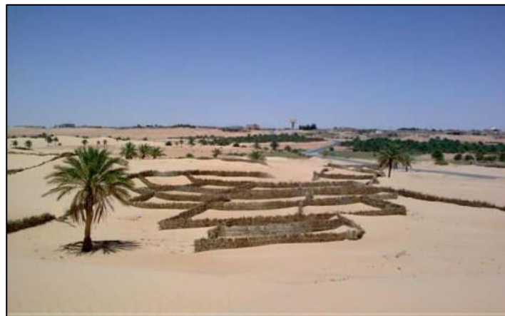
Figure I-9 : Carroyage de palmes destinées à protéger la section routière à Tindouf
