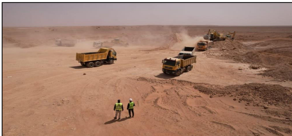
Figure I-1 : La zone de projet Béchar – Gara Djebilet (ENSABLEMENT INTENSE)
