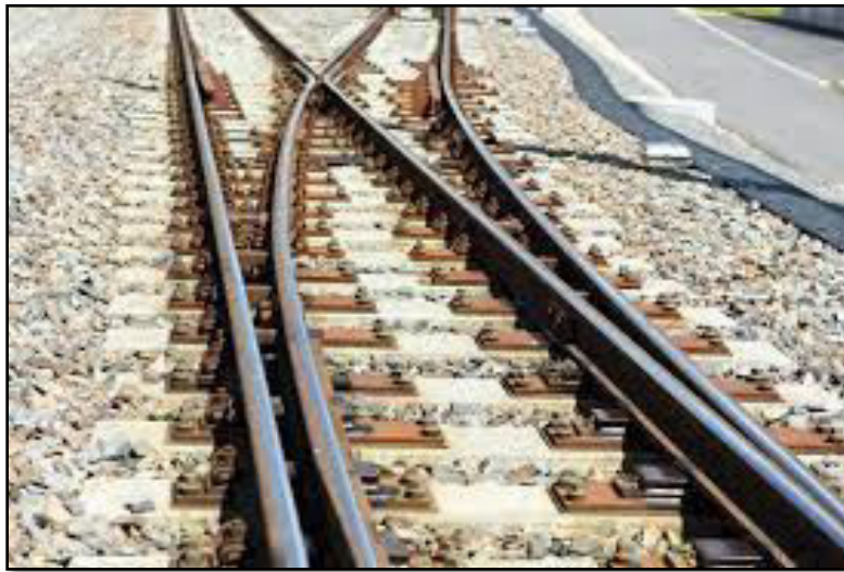
Figure III-8 : L'appareil de voie ADV
