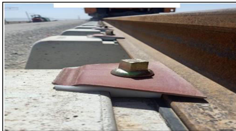
Figure III-7 : : Les attaches Nabla
