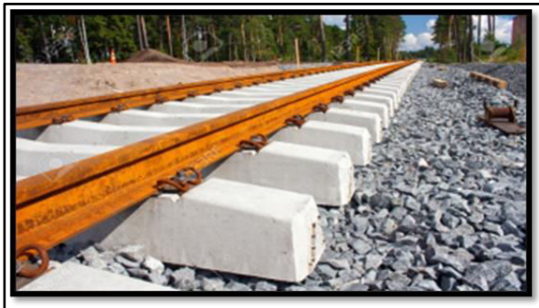
Figure III-4 : Travers en béton
