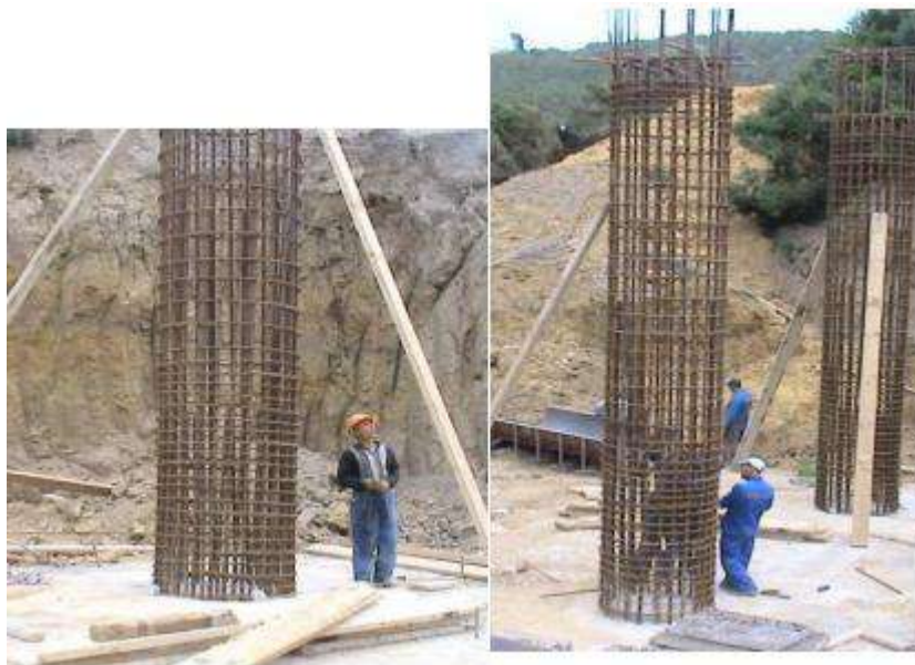
Figure XIII.6: mise en place du ferrailage du fut
