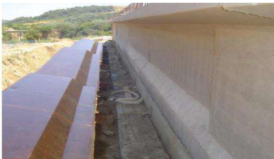
Figure XIII.14 : la forme de la poutre après décoffrage
