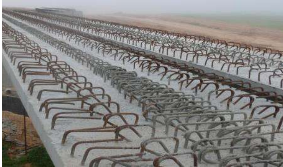
Figure XIII.11 : exemple sur armatures de jonction
