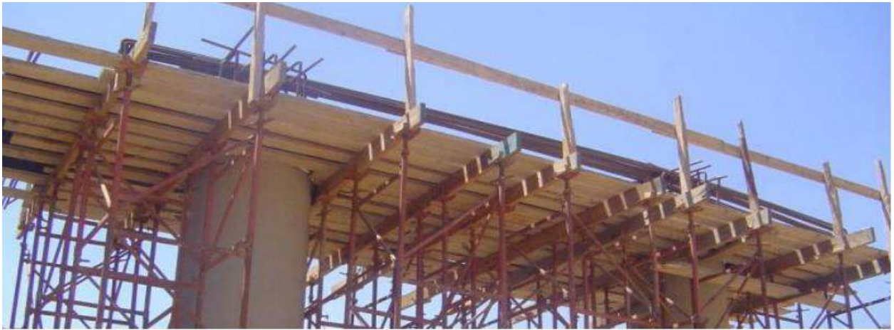
Figure XIII.8 : ferrailage chevêtre
