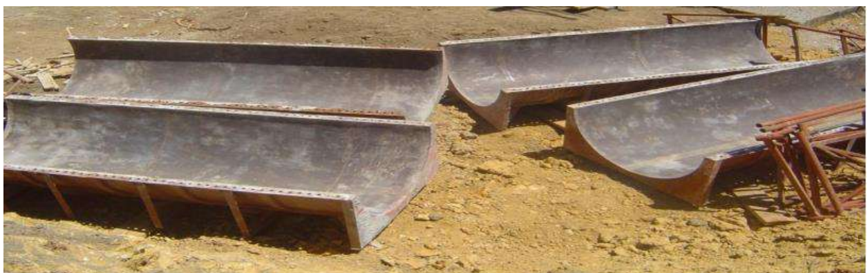
Figure XIII.7 : coffrage du fut
