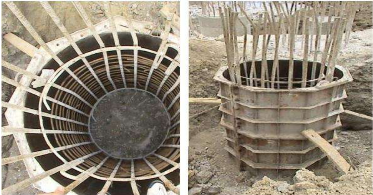
Figure XIII.3 : armatures de pieu
