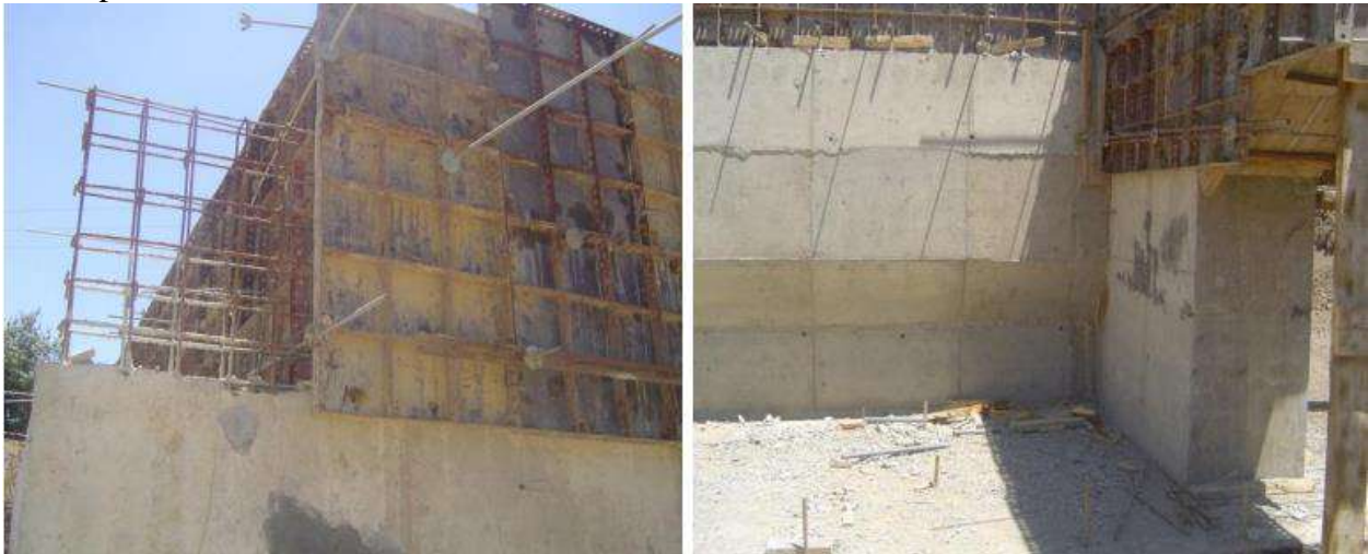
.Figure XIII.9 : coffrage du mur en retour.
