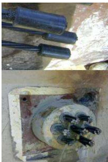
Figure XIII.15 : exemple sur l'ancrage fixe
