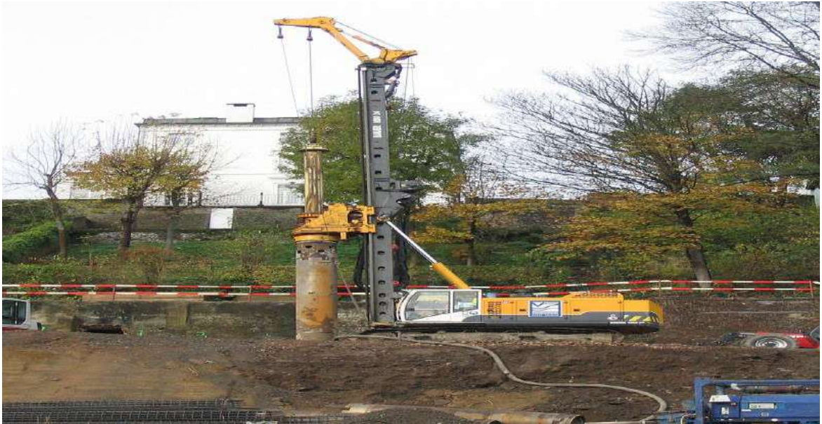
.Figure XIII.2 : le forage des pieux
