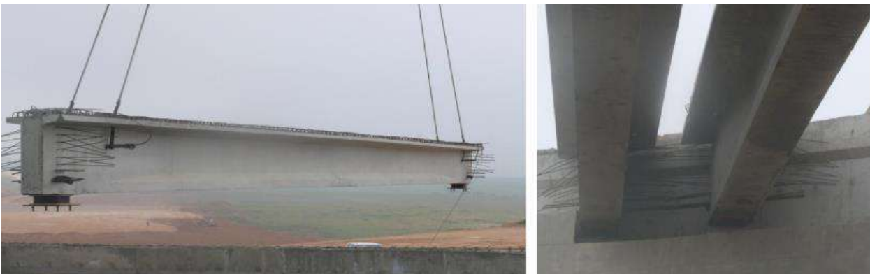
Figure XIII.10 : pose des poutres
