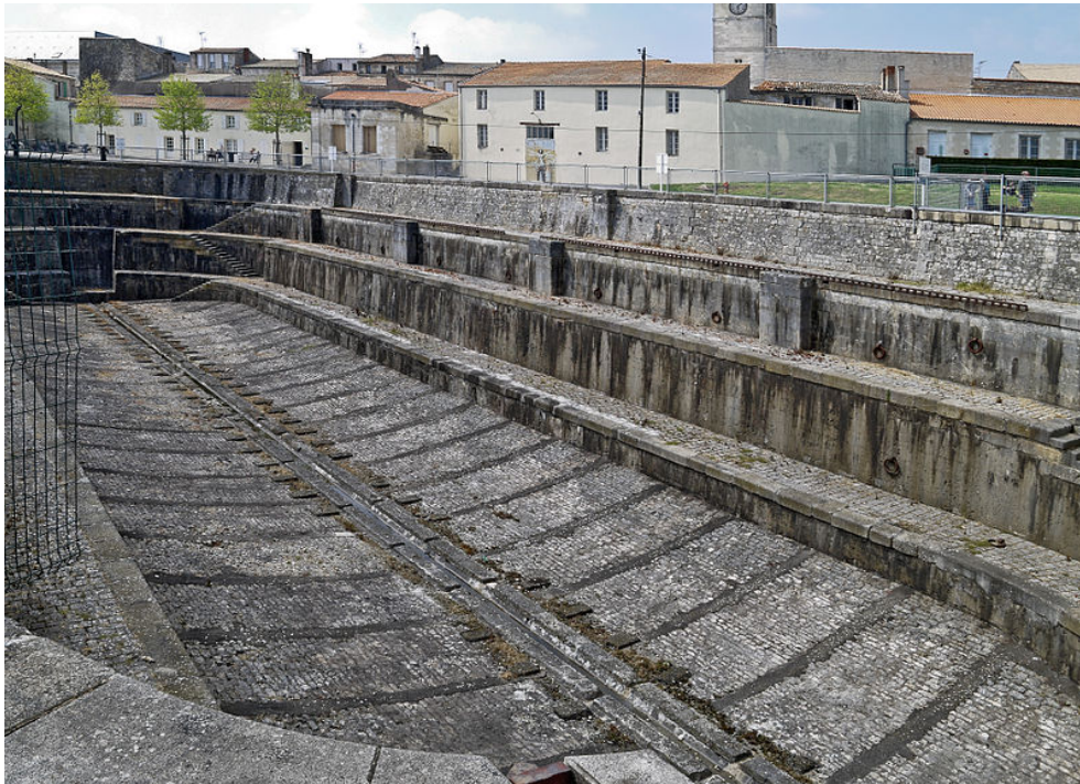
Figure III.4. La forme supérieure de la « forme double » à Rochefort, conçue au XVIIe siècle.
