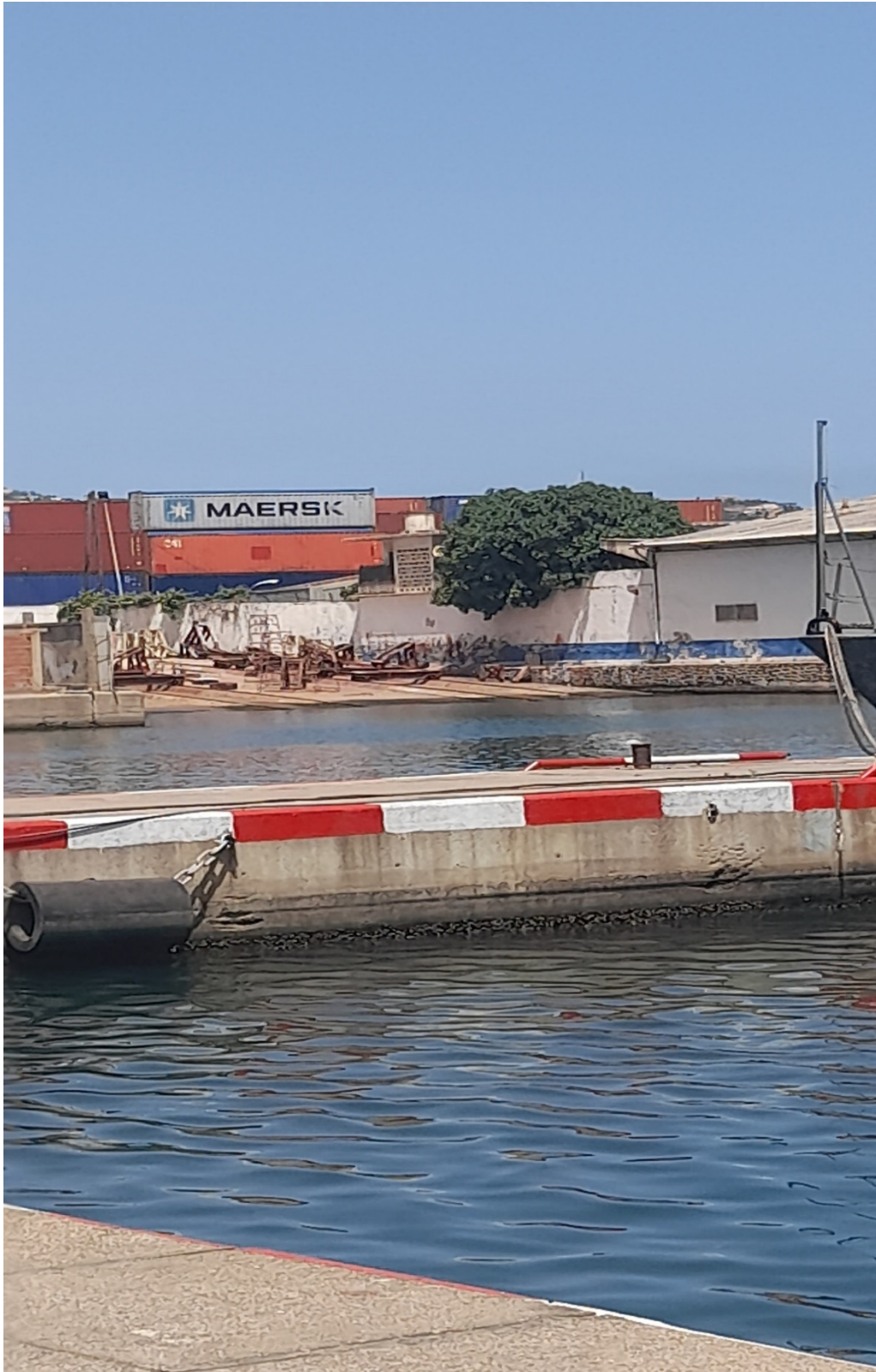
FigureA.1. Photo réelle de la cale de halage existante
